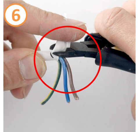
Відріжте зовнішню ізоляцію до мітки.
